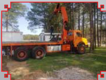
جابجایی اتاق نگهبانی در حفاری
