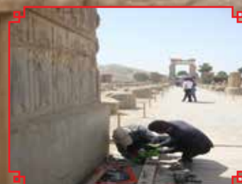
بهسازی کف پوش های مسیر بازدید کننده
