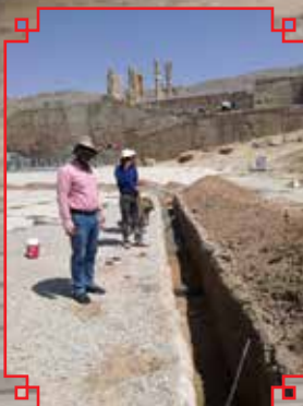
لوله گذاری جلوی پلکان ورودی
